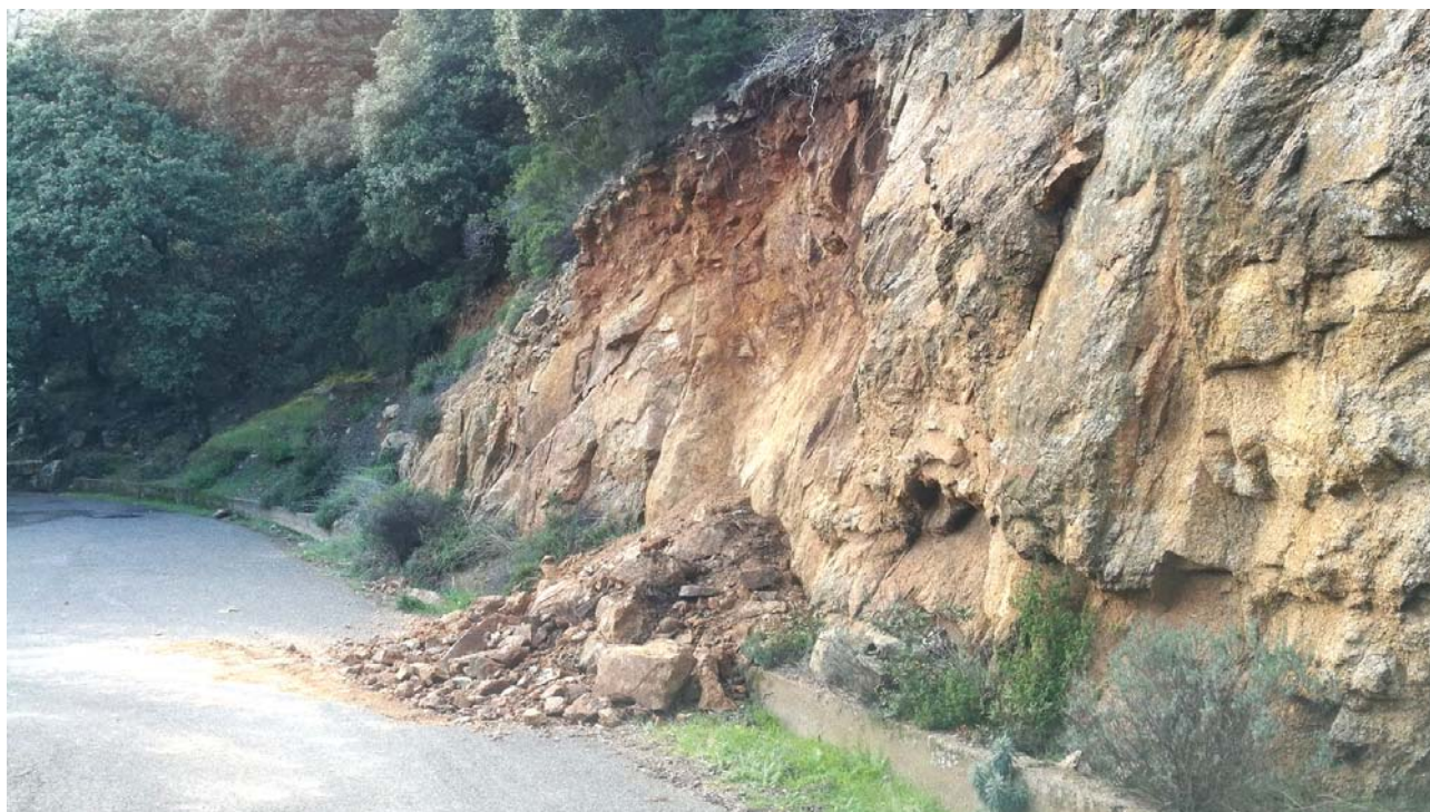
Foto – Strada Comunale Fluminera-Genna Frocciddaras-Coxinas
