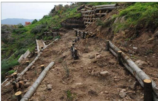
Briglia in legname e pietrame associata a viminate e palizzate. In fase di realizzazione (marzo 1999)
