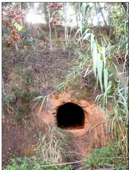
Foto – Imbocco di una delle gallerie nel settore Sant'Antonio
